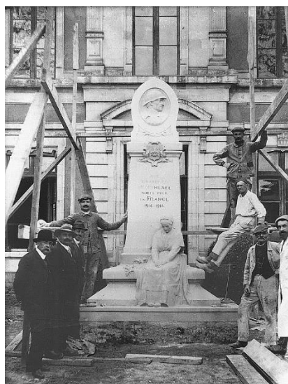
Construction du monument aux morts de Saint-Florent-le-Vieil. Archives dép. de Maine-et-Loire, 4 Fi 911
