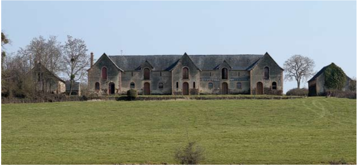
Aile ouest de la ferme modèle du domaine des Rues (1 sur le plan ci-dessous). La façade apparaît très sobre et marquée du sceau de la rationalité : succession régulière de frontons-pignons aux lignes épurées, répartition symétrique des baies en plein cintre.
